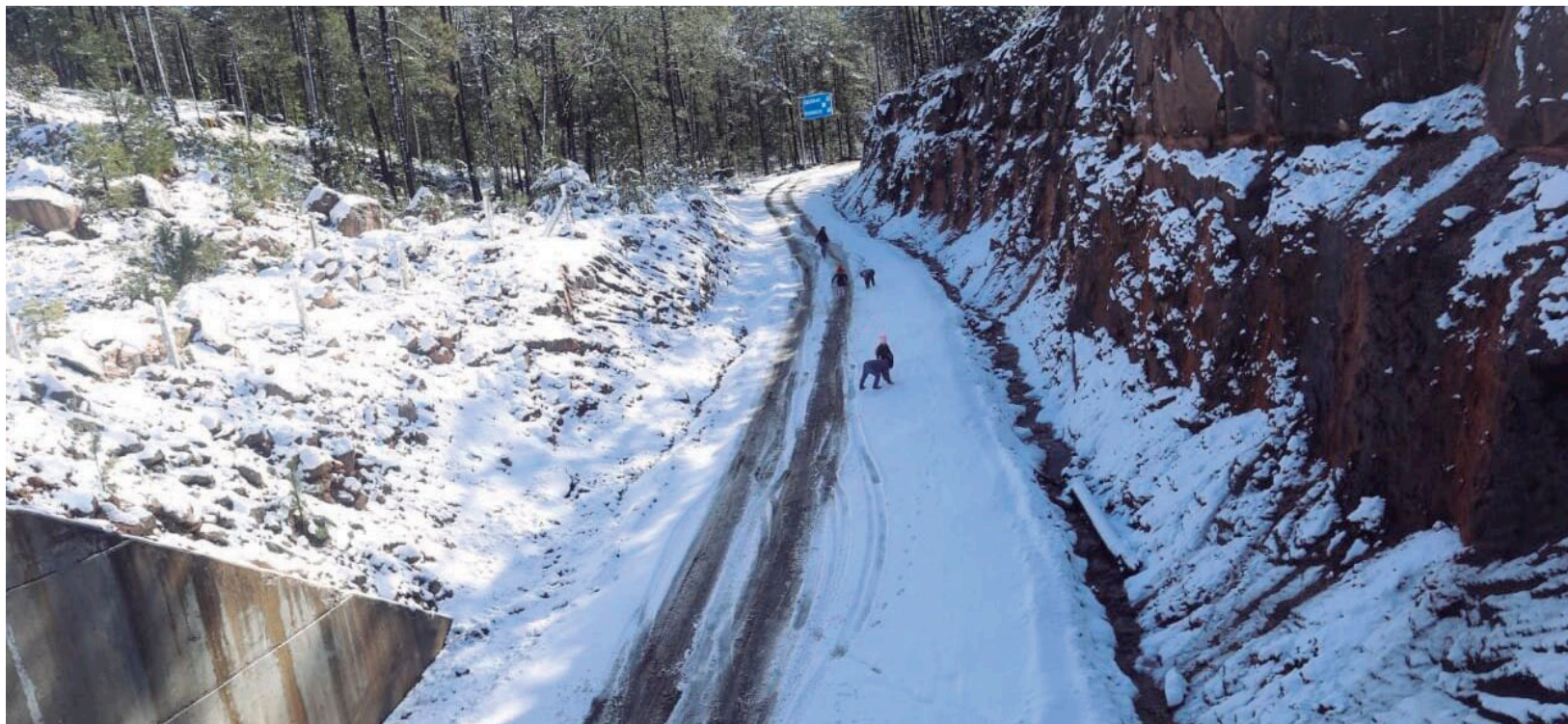
Una gruesa capa de nieve cubre la carretera Mazatlán-Durango en varios kilómetros, lo que provocó el cierre de esa vía de peaje ante la dificultad para transitar por ella
