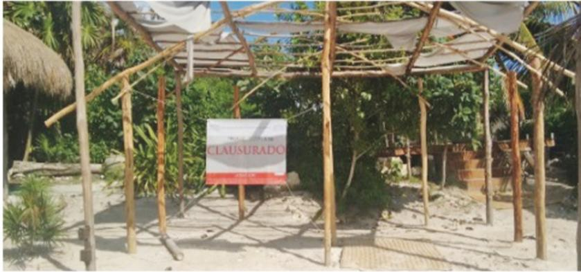
de bambú en forma triangular amarrada con cuerdas de henequén y que se encuentra enterrada en el sustrato arenoso sostenido por material rocoso de la región, y en ella una mesa de madera con cables y conexiones de corrientes para conectar equipo de
