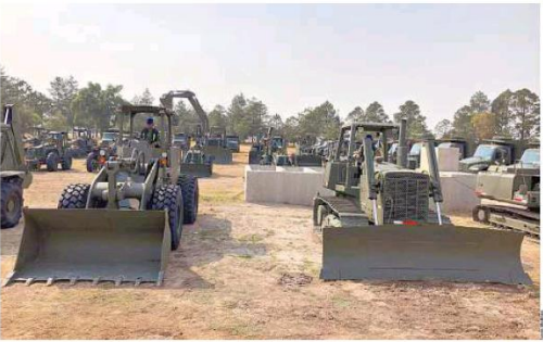
Las obras en el aeropuerto Santa Lucía. / Agencia Reforma
