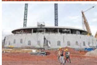
OBRA de la Torre de Control.
