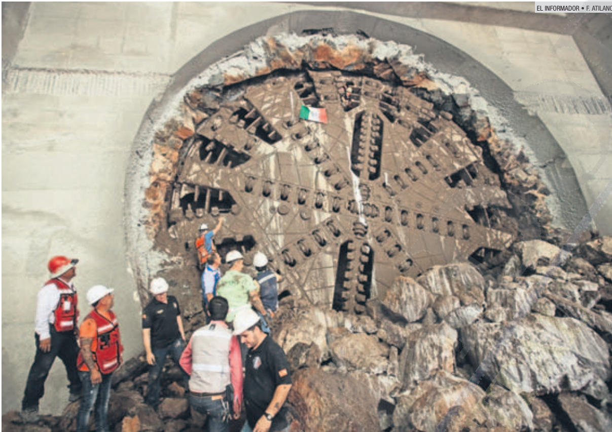
DÍA HISTÓRICO. “La Tapatía” concluyó ayer el túnel de 4.5 kilómetros que cruza el Centro tapatío. Ahora inicia el desmantelamiento de la máquina.
