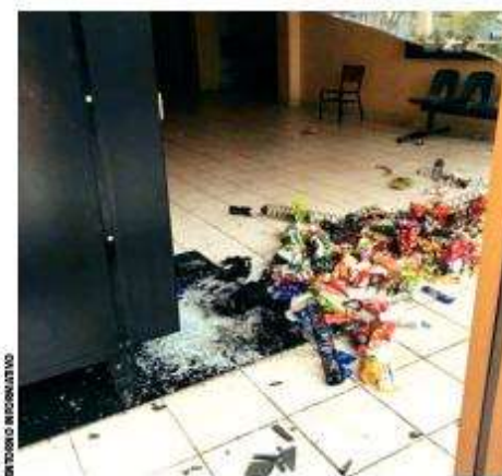
Los daños que causaron los delincuentes en las instalaciones de la UTH
