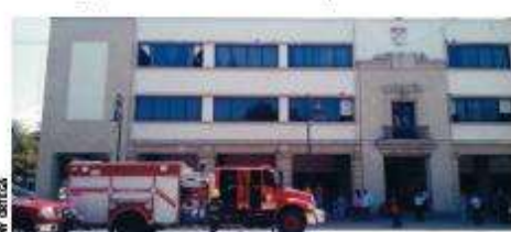
Elementos de bomberos acudieron al Palacio Municipal al registrarse la presencia de humo causado por un desperfecto en el motor de un aire acondicionado
