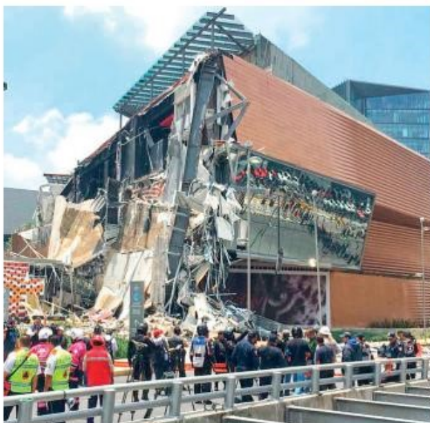
PGR informó que el derrumbe en la plaza comercial Artz ocurrió "derivado de un sobrepeso que se originó en la terraza que se encuentra en el último nivel".
