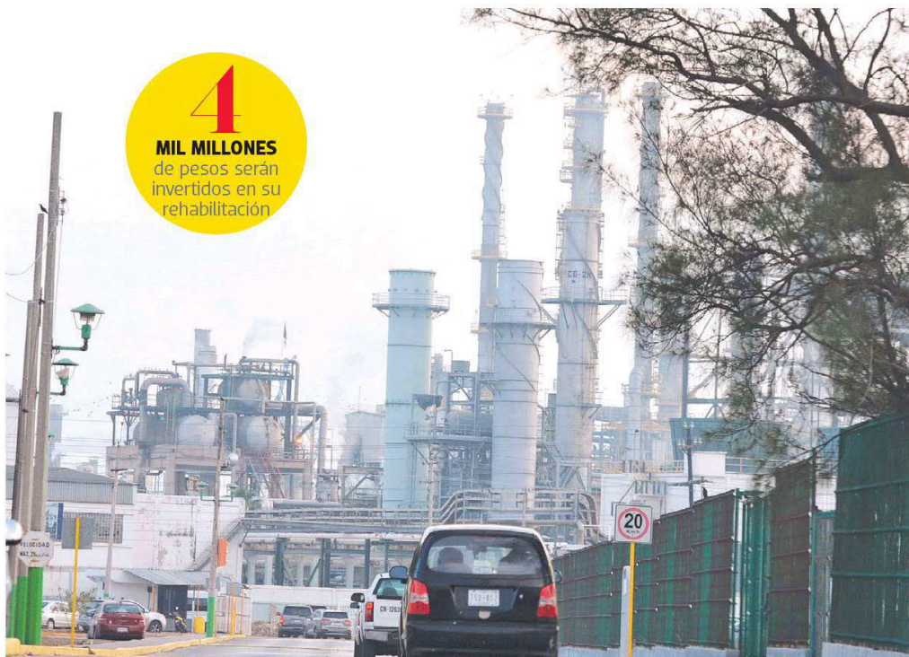
Con la misma mano de obra de Pemex se realizarán la mayoría de las reparaciones / ANTONIO SOSA
