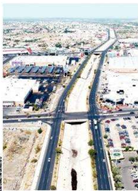
Fueron 40 mil metros cuadrados los que se rehabilitaron en el Paseo Río Sonora y la calle Doctor Domingo Olivares
